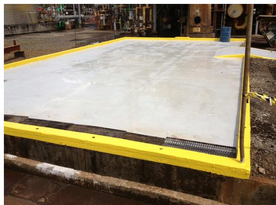
Figura 26 – Pátio de Hidrojateamento com impermeabilização concluída.
