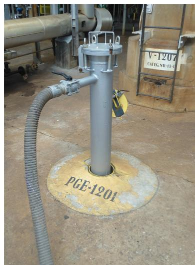
Figura 28 – PGE-1201: Poços de extração multifásica
