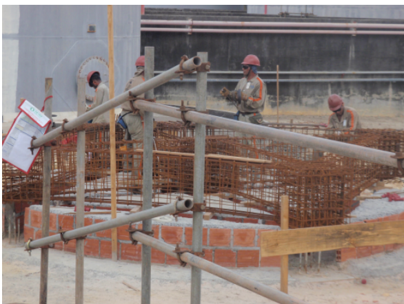
Figura 20 – Ampliação das Plantas de LAB - Construção inicial de fundações para receber novos equipamentos.
