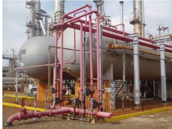
Figura 43 – Sistema fixo de combate
