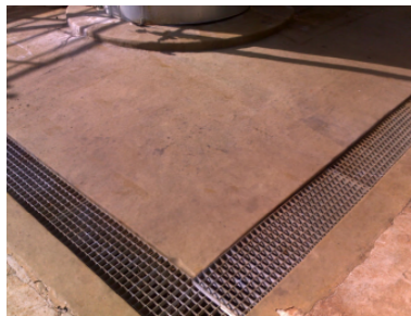
Figura 25 – Manutenção de pisos e sistema de drenagem.
