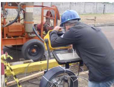
Figura 24 – Uso de sistema de televisãoamento nas inspeções
