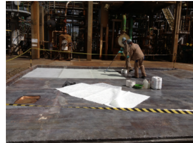
Figura 26 – Impermeabilização do Pátio de Hidrojateamento.
