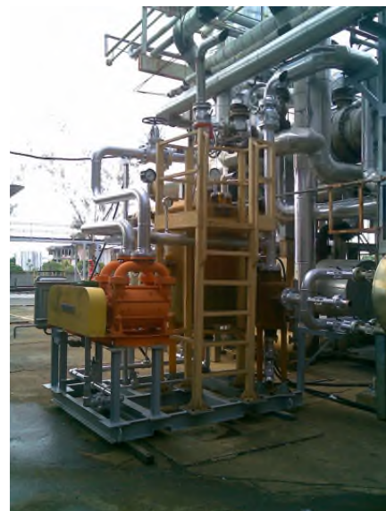
Figura 30 - UEG III - Unidade de Extração de Gás instalada na DETEN II
