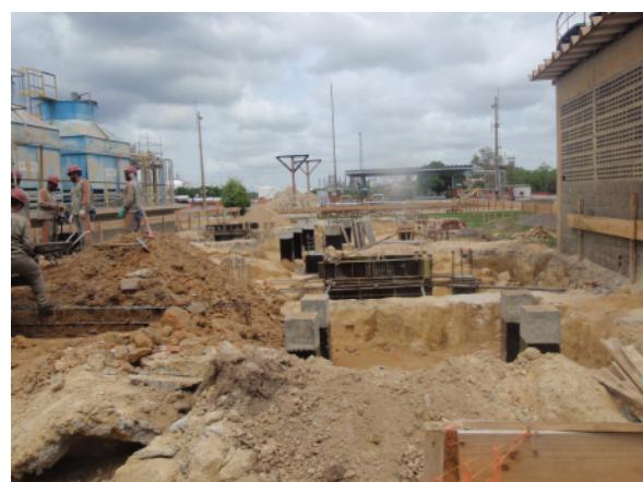
Figura 20 – Ampliação das Plantas de LAB - Construção inicial de fundações para receber novos equipamentos.
