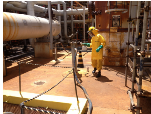
Figura 28 – PGE-312- poços de extração multifásica instalados dentro da área ácida DETEN I.
